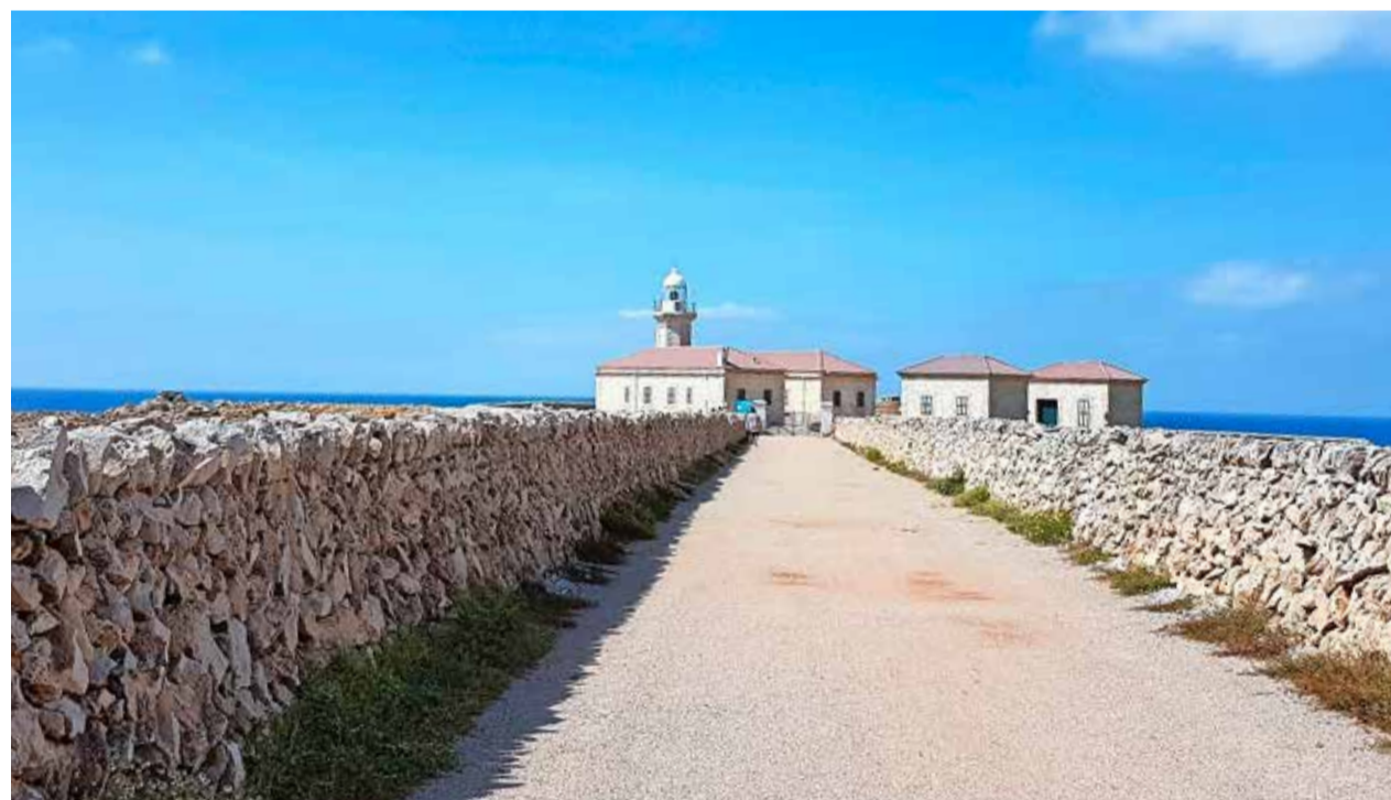
Die mannshohen uralten Steinmauern, erbaut ohne Mörtel und Zement, sind typisch für Menorca.
