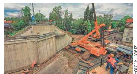
Arbeiten an der Brücke Wangen
