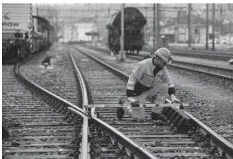
Abbildung 11: Dank dem Einsatz der leitsystemunterstützten Warnung erhöht sich die Sicherheit und sinken die Kosten auf Baustellen.
