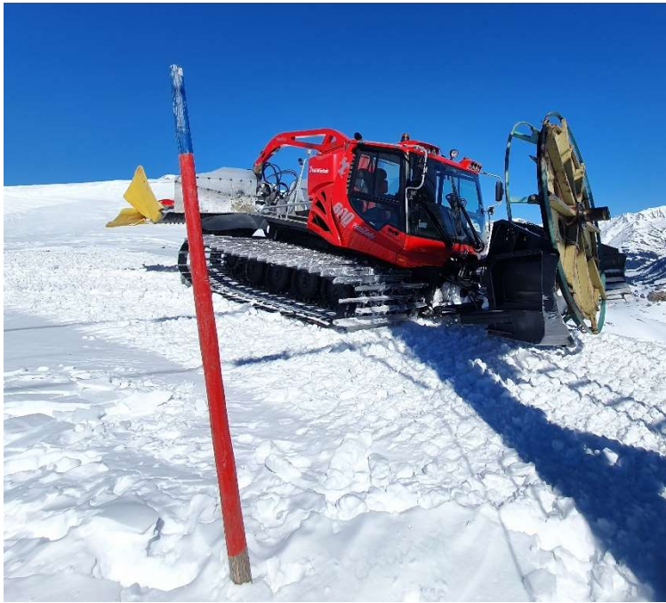
Abtransport der Umlenkscheibe bei der Bergstation des Skilifts Alp da Munt – Minschuns mit dem Pistenfahrzeug (Foto: Sportanlagen AG Val Müstair).
