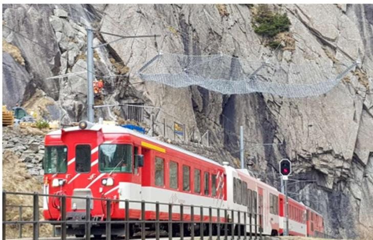
Hochwasser im Goms (MGBahn) / Steinschlagbarriere an der Teufelswand in der Schöllenen ([www.geobrugg.com](http://www.geobrugg.com))
